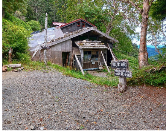
徳本峠小屋 手前の古い建物は登録有形文化財
