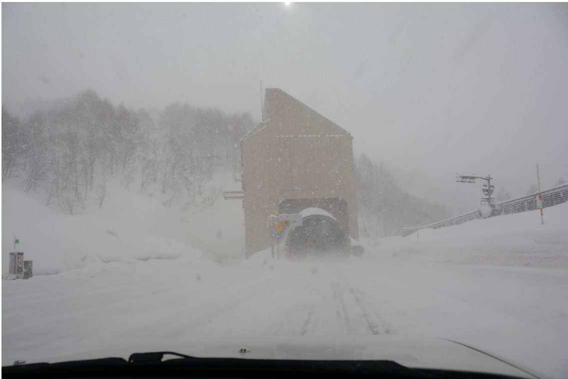
月山第一トンネル鶴岡側入り口（2014年2月6日撮影）
