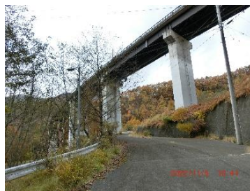
雁坂トンネル高架橋
