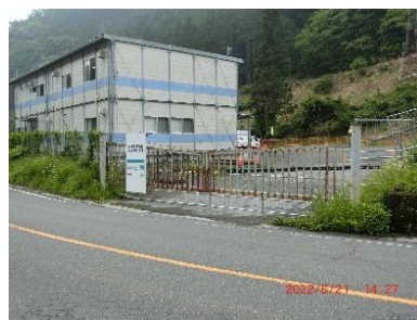
東京発電(株) 改良工事宿舎
