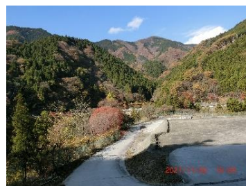
二瀬ダムの土砂置場
