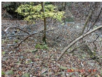
土砂で埋まった堰堤
