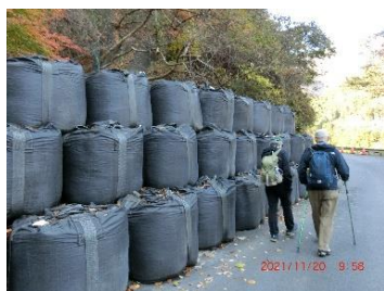
斜面崩壊防止の大型砂利パック
