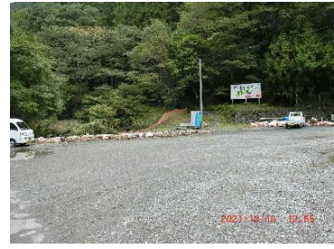
白滝沢の工事現場
