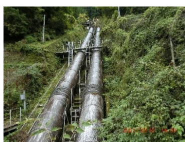
大滝発電所の送水管
