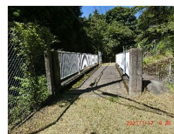
送水管の陸橋
