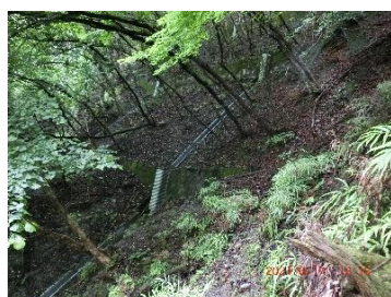
林道終点の沢の排水路
