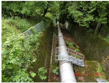
送水管の下部
