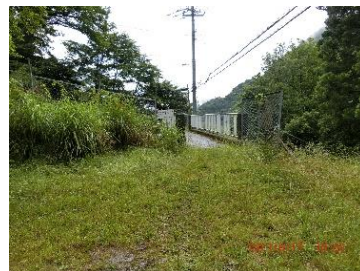
送水管の陸橋
