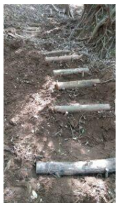
木製の階段を設置
